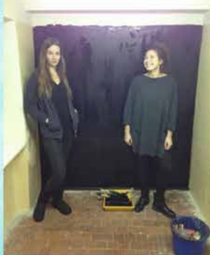
Remontējot SP kabinetu
